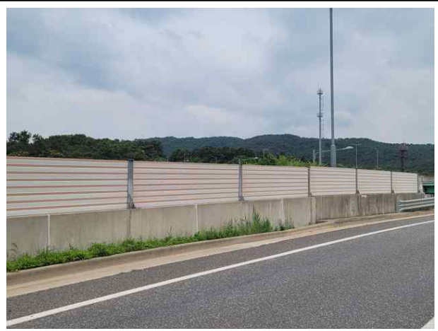
난간 및 연석 전경
