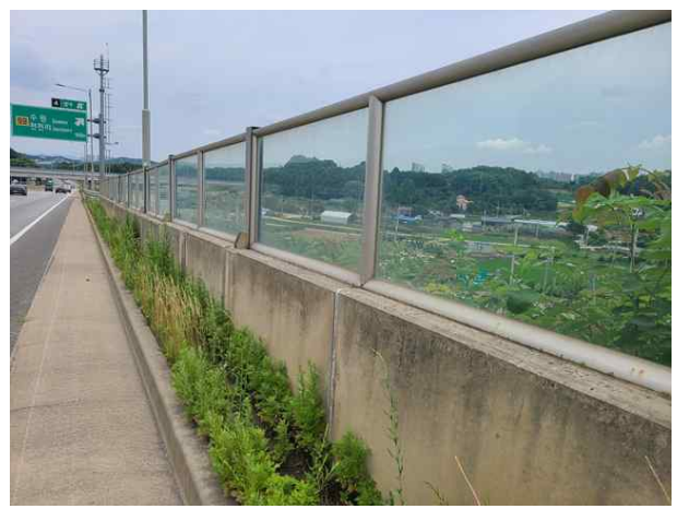
난간 및 연석 전경
